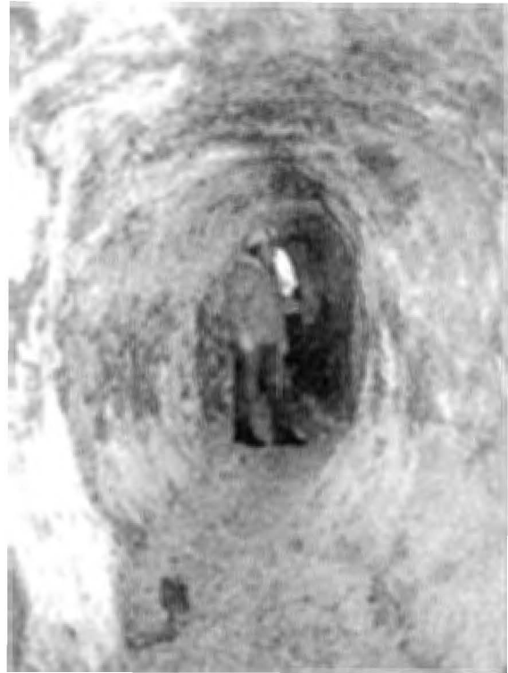
Silberstuben, Tschirgant, Stollen 7: Vortriebsfeuersetzungen im tauben Karbonatgestein, Blick in Richtung Mundloch, im Bild: M. Brewel (Foto und Archiv Gstrein)
